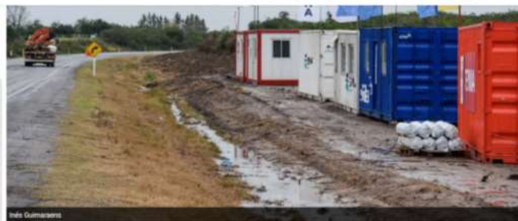
Contenedores de las empresas constructoras en la ruta 43
